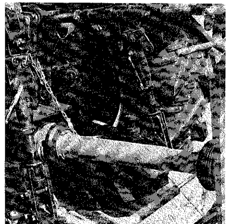
Schutzrohre vorhanden und gegen Drehen durch Ketten gesichert.
