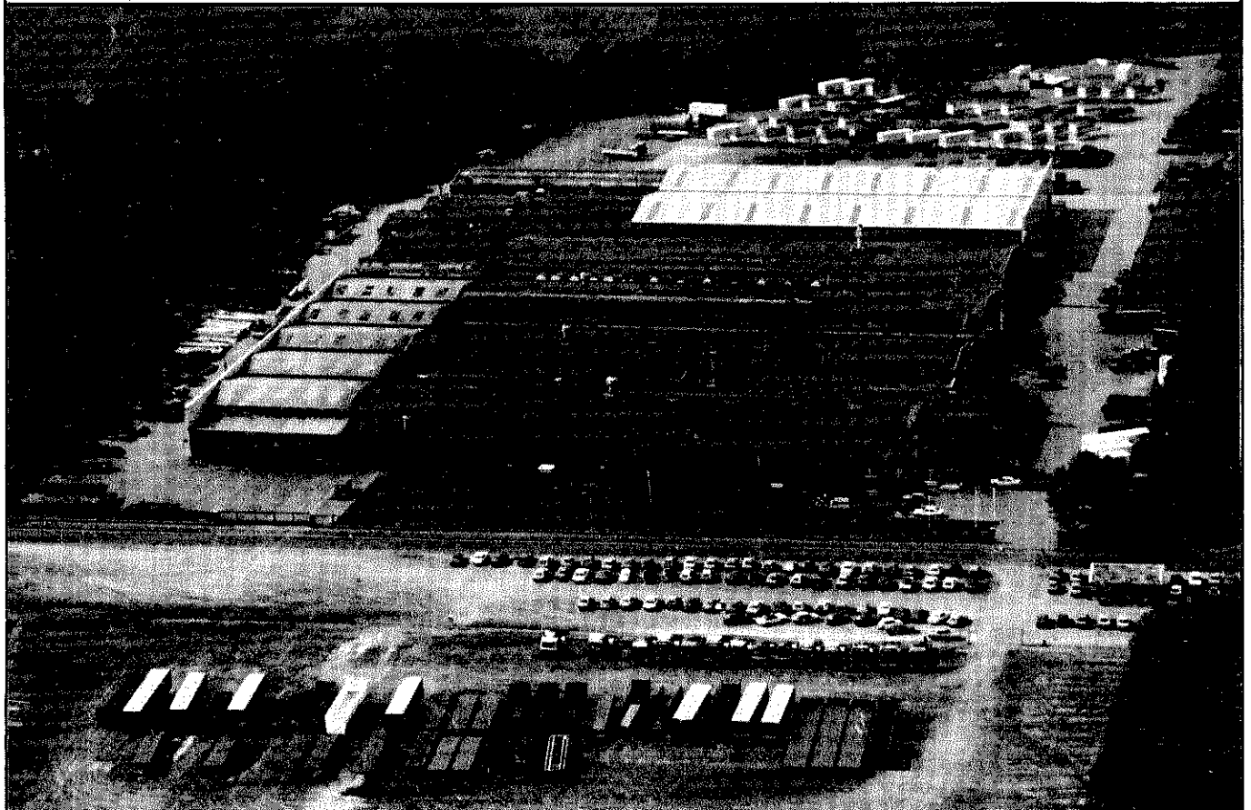
Unser Werk II in Werlte, Gesamtfläche 110 000 m 2 , überdachte Fläche 30 000 m 2
